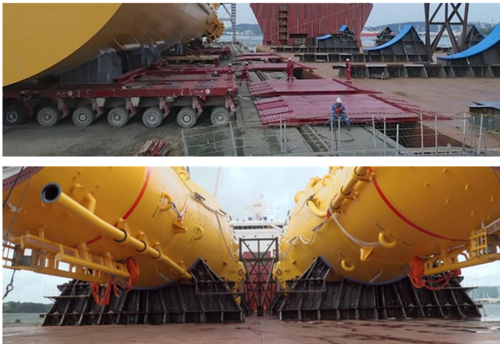
Abbildung 7: Verladung und Lagerkonstruktionen für Hywind-Spar-Buoys [15]
