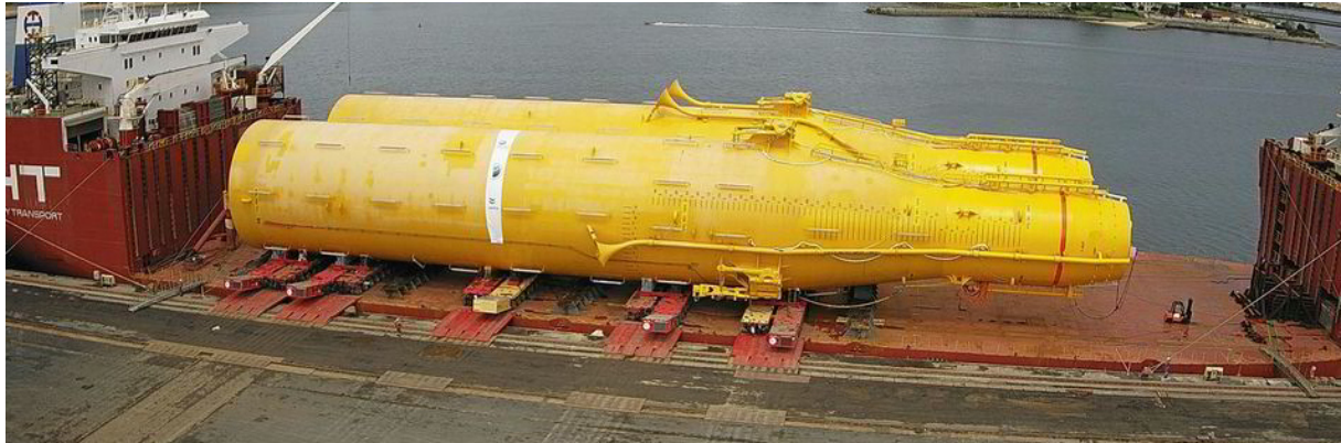
Abbildung 13: Hywind-Spar-Buoy und konstruktive Kopplungsstellen / Secondary-Steel-Anbauteile [17]
