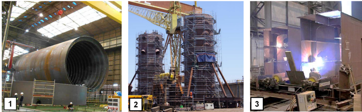
Abbildung 3: Beispielhafte Designvariation schwimmender Unterstrukturen (1 - Fertigung einer Spar-Buoy-Struktur [8]; 2 - Bau einer Semi-Submersible-Struktur im Trockendock [9]; 3 - Auszug TLP-Fertigung von GICON [10])
