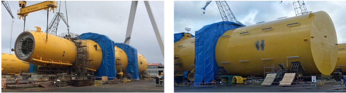
Abbildung 6: Exemplarische Konservierung einer Spar-Buoy [14]
