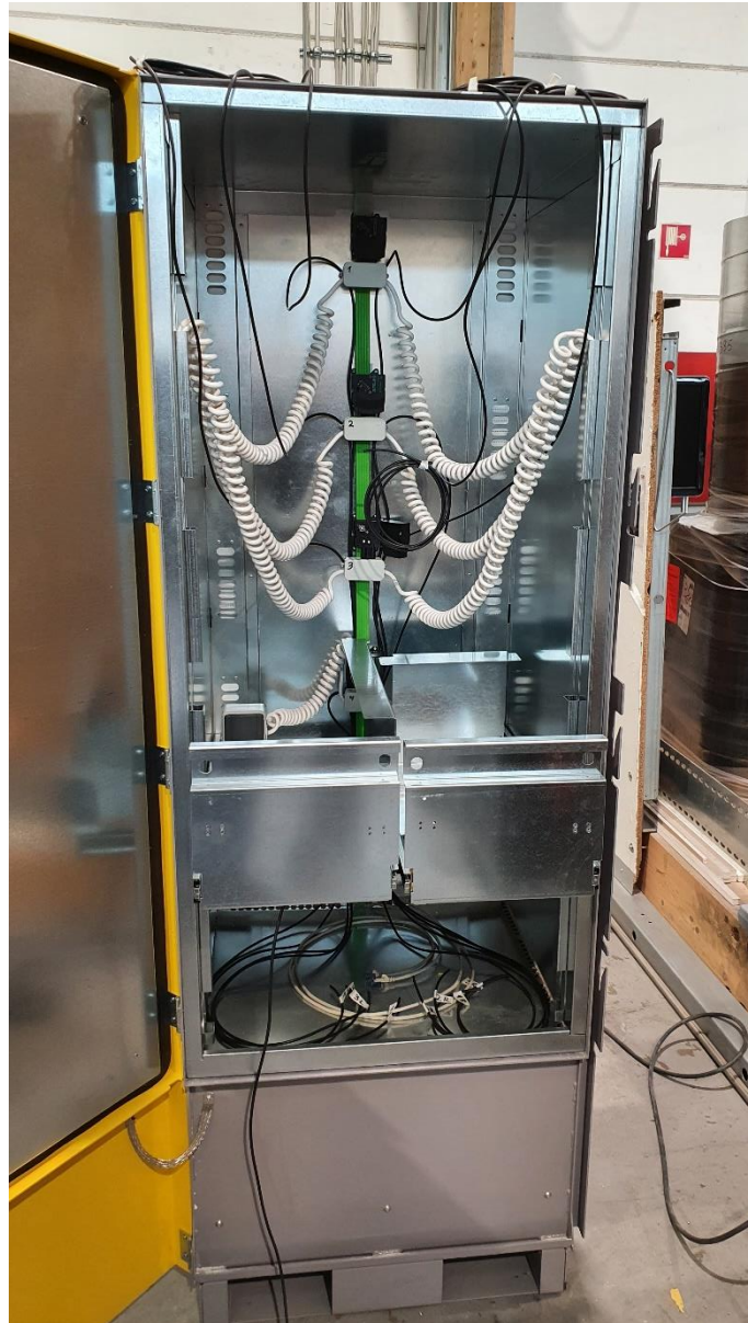
Abbildung 3-40 - StrainLock im Aufbau mit Strom- und Datenkabeln
