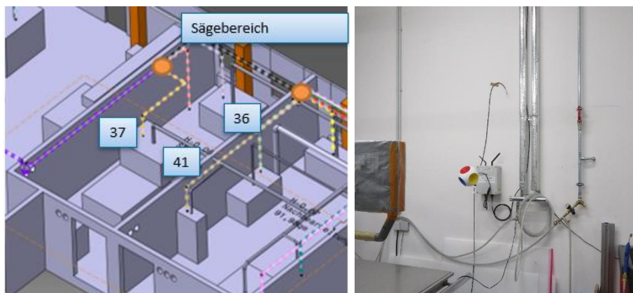
Abbildung 13: Sensorknotenverteilung in dem Fertigungsraum „Sägebereich“ und beispielhafter Sensorknoten „37“
