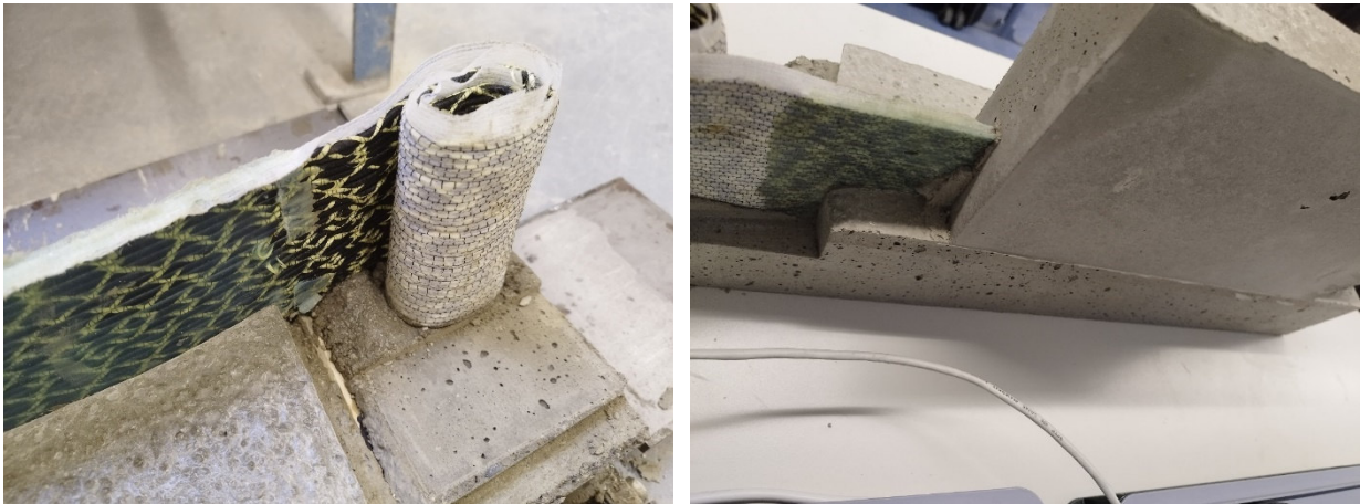
Bild 21: Eingebautes auxetisches Fugenband (links) und fertiger Demonstrator (rechts)
