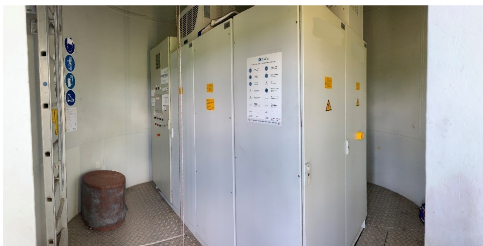
Abbildung 2.21: Schaltschrank des Hauptumrichters der Windenergieanlage
