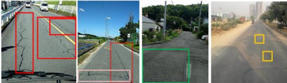
Abbildung 76: Beispiele für Straßenschäden aus den Lerndaten des Road damage detection datasets (Ref. siehe Haupttext). Von links nach rechts sind die vier Klassen zur Objektdetektion dargestellt: Längsrisse (rot), Querrisse (rosa), Alligator cracks (grün) und Schlaglöcher (gelb).
