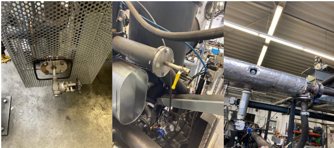
Abbildung 26 Messstellen zur Gasentnahme direkt nach dem Reformer (links), nach der Filtereinheit (mitte) und am Übergang zu BHKW (rechts).
