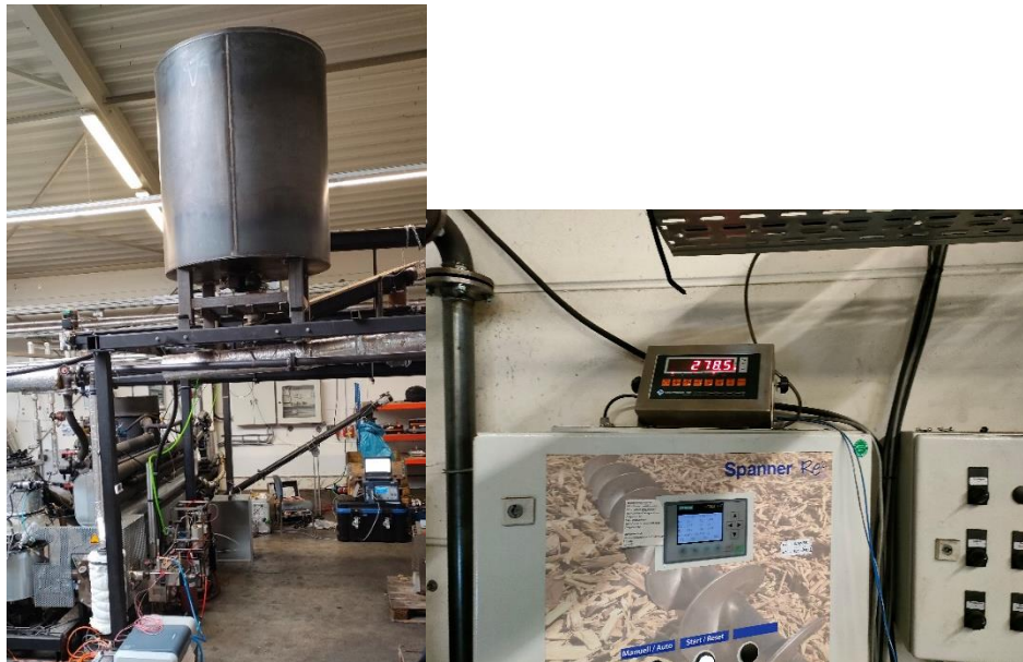
Abbildung 27 Brennstoffbunker mit Wiegesystem der zur Bilanzierung genutzt wurde.
