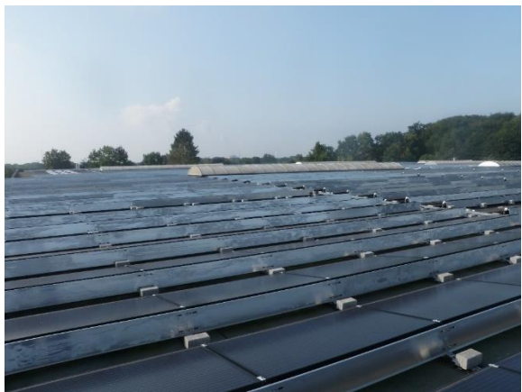
Dachkonstruktion mit Aerodynamikelementen
