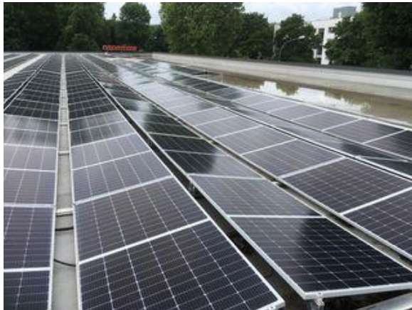
Dachkonstruktion Ost-West Ausrichtung
