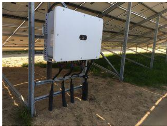
Strangwechselrichter an Unterkonstruktion
