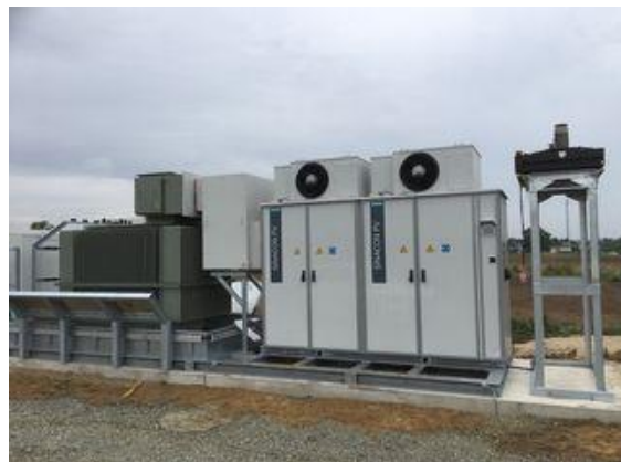
Zentralwechselrichterstation mit MV-Transformator
