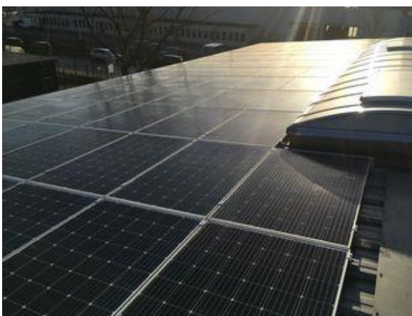
Dachanlage auf Schrägdach, dachparallel
