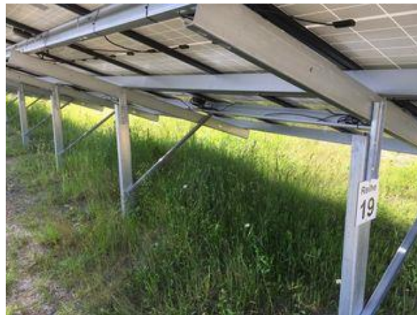
Unterkonstruktion mit 1-Punktverankerung
