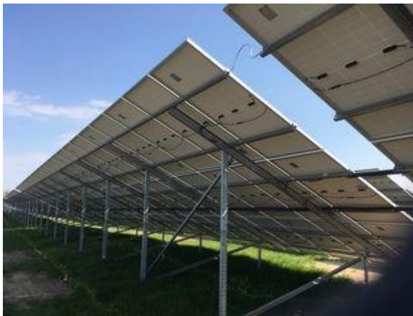
Unterkonstruktion mit 2-Punktverankerung
