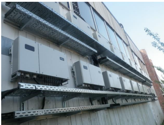
Strangwechselrichter an Gebäudewand
