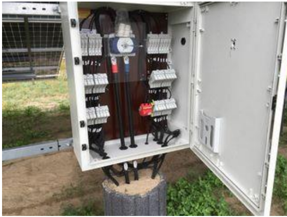
Generatoranschlusskasten
