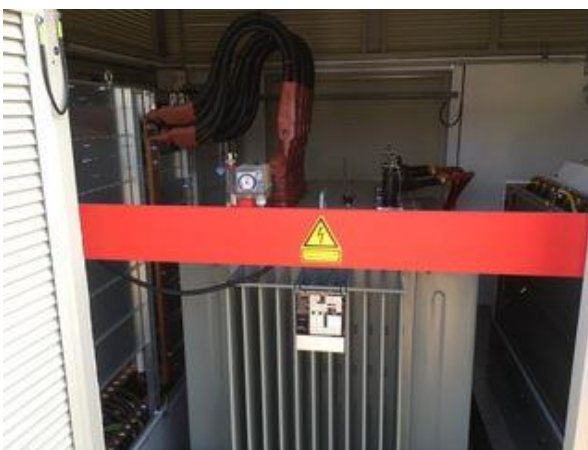
Mittelspannungstransformator
