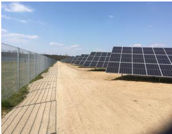
Freifeldanlage, starr nach Süd ausgerichtet
