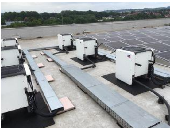
Strangwechselrichter Bodengerät
