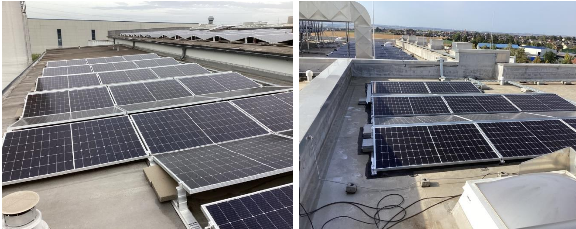
Dachanlage auf Flachdach, aufgeständert Ost-West-Ausrichtung
