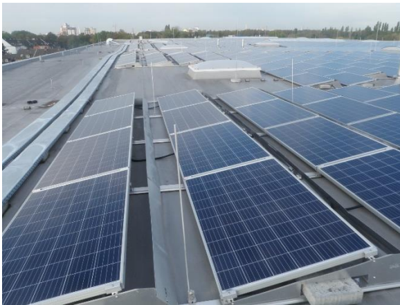
Dachanlage auf Flachdach, aufgeständert
