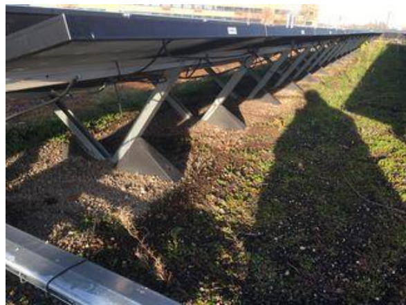
Dachunterkonstruktion mit Schüttung
