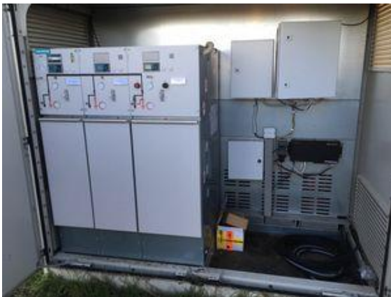
Mittelspannungsschaltanlage
