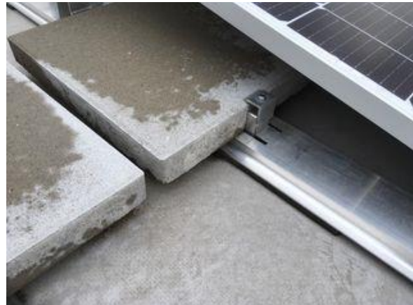
Dachkonstruktion mit Ballastierung
