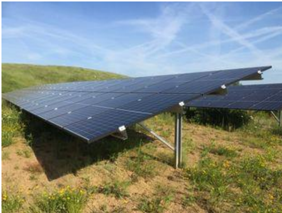
Freifeldanlage, gerammte Unterkonstruktion
