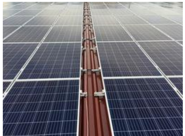
Dachparalleles Schrägdachsystem
