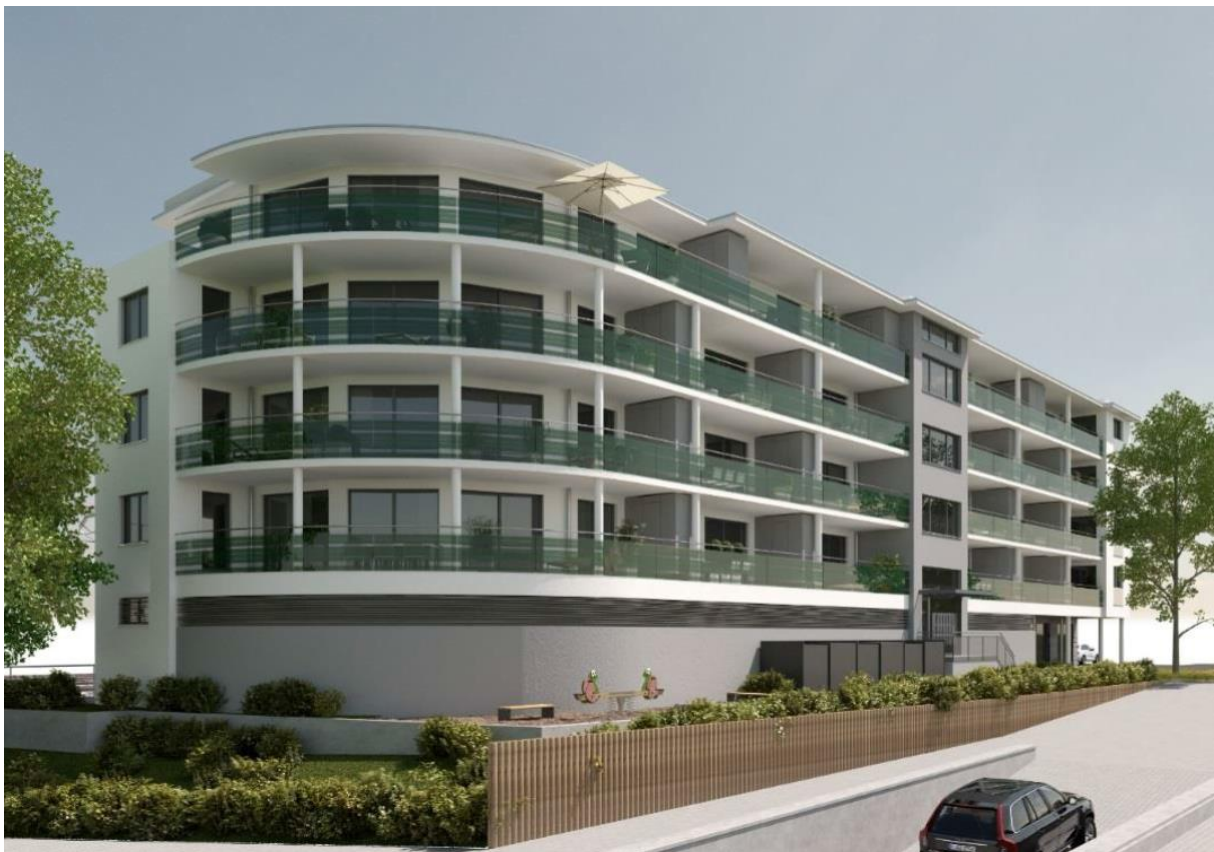
Abbildung 9 – Organische Photovoltaik integriert in den Balkonbrüstungen an der Südfassade (Quelle: Böhme Hilse Architekten)
