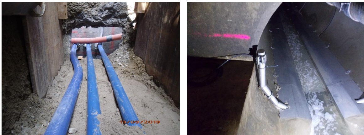
Abbildung 18 – Fotos der Anbindeleitung und des Einbaus des Wärmetauschers
