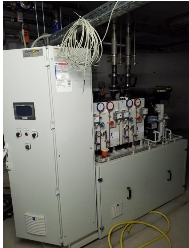
Abbildung 12 – Zeichnung und Foto der Wärmepumpe (Quelle Abb. links: CombiTherm)
