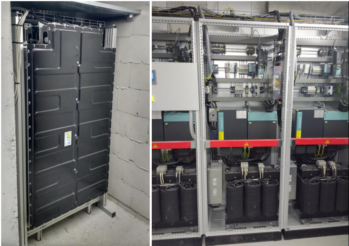
Abbildung 17 – Fotos der Stromspeicher
