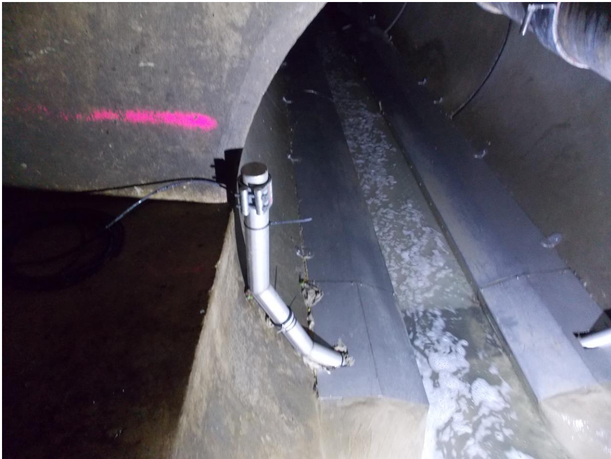
Abbildung 14 – Foto des Abwasserwärmetauschers
