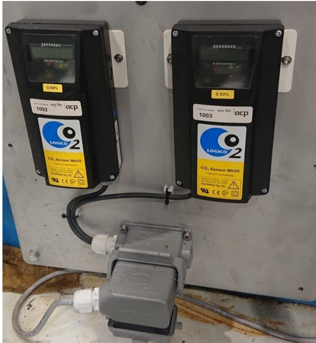
Abbildung 6: redundante CO2-Gaswarnsensoren/Sicherheitstechnik
