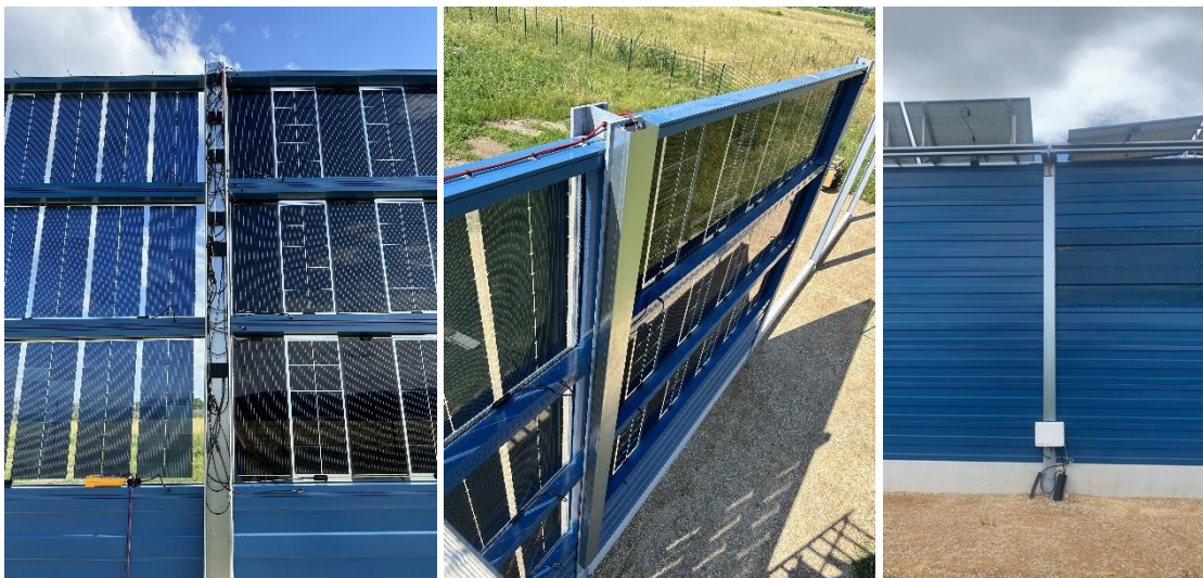
Abbildung 61: Fotos der Montage von Kabelkanälen, Leistungsoptimierern und Wechselrichtern
