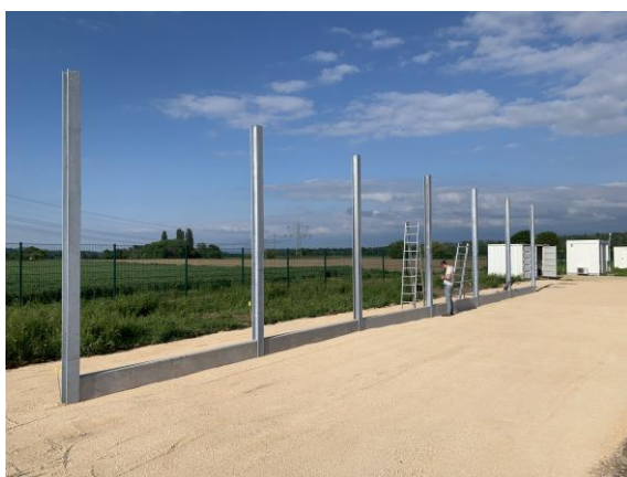
Abbildung 67: Fotos vom Bau der Lärmschutzwand in Merdingen
