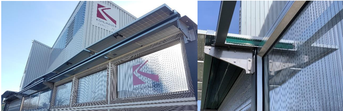
Abbildung 16: Links: PV-Aufsätze Kohlauer Parkplatz Gaggenau, Rechts: Detailfoto einer Aufsatzvariante mit schalldichtem akustisch absorbierendem Aufsatz
