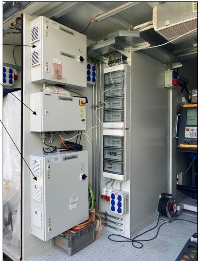
Abbildung 13 Montage der Steuerungsboxen SCeye und QH6D
