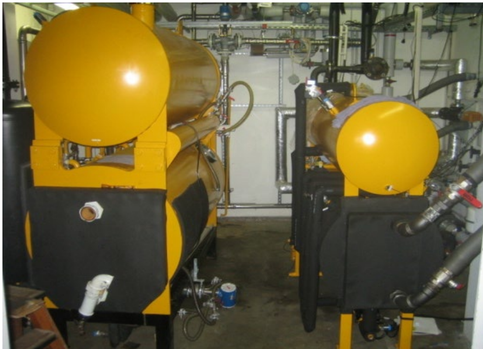
Abb. 1-1: Absorptionskälteanlage Typ Biene (rechts) und Typ Hummel (links).
